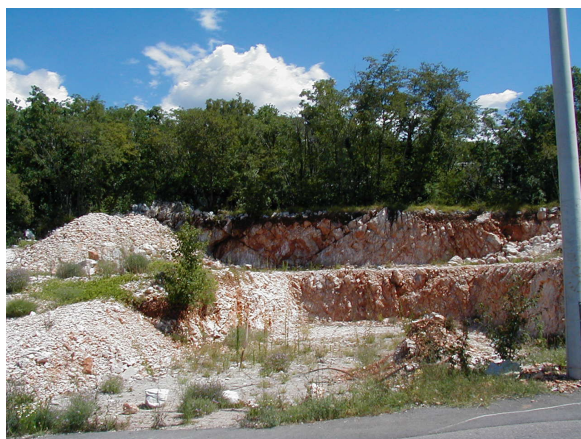
Slika 3. Priprema zemljišta za gradnju - sastav tla (stijena)
