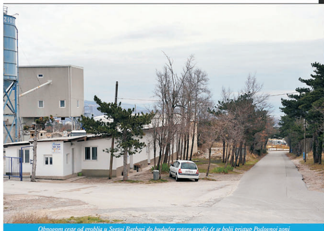
Obnovom ceste od groblja u Svetoj Barbari do budućeg rotora uredit će se bolji pristup Poslovnoj zoni
