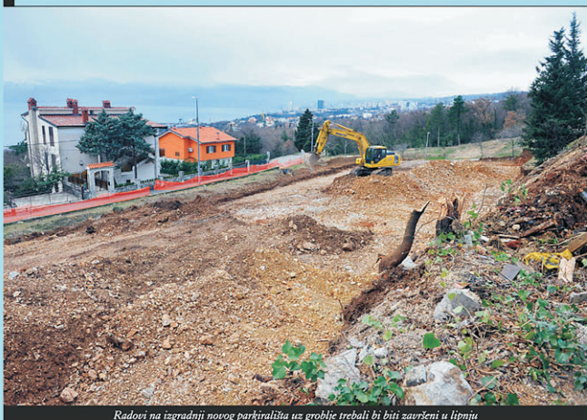
Radovi na izgradnji novog parkirališta uz groblje trebali bi biti završeni u lipnju
