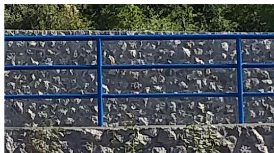
Metalna ograda (toredna)
