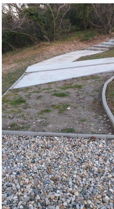
Slika 4. Nedovršeni dijelovi staze: priprema u vidu lijevanog betona ispod kote rubnjaka i pijesak
