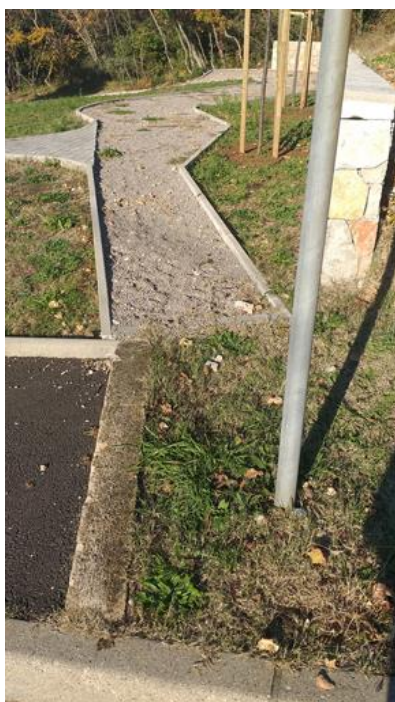
Slika 3. Neusklađeni izlaz na prometni znak, nedefinirani kraj staze i Zelena površina uz zid
