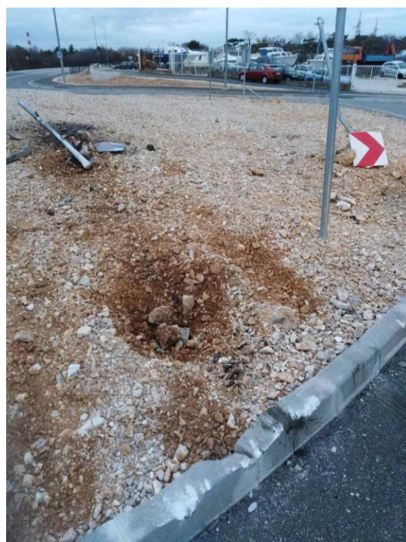
Oštećenja rubnjaka i prometnih zbog vožnji neprilagođenom brzinom (prosinač, 2019.)
