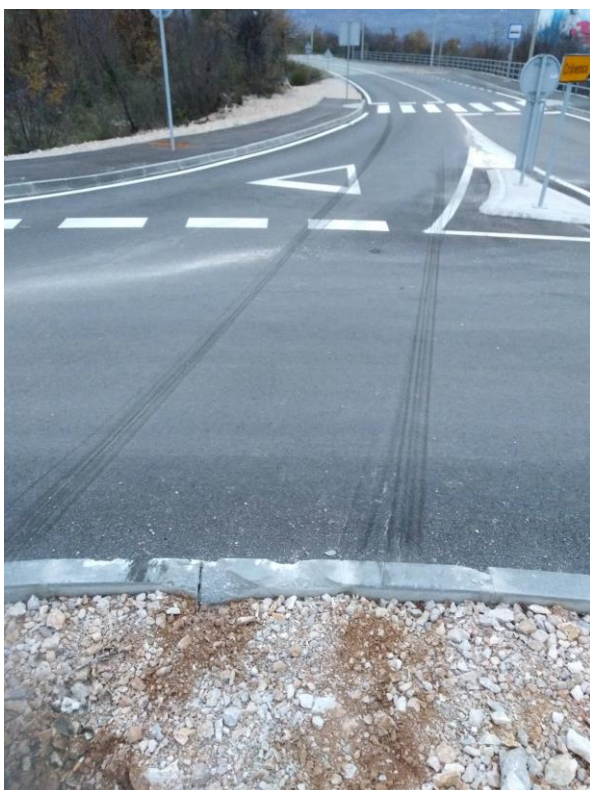
Oštećenja rubnjaka i prometnih zbog vožnji neprilagođenom brzinom (prosinač, 2019.)
