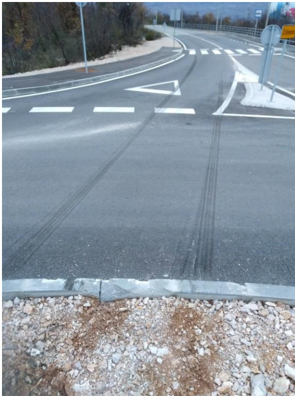
Oštećenja rubnjaka i prometnih zbog vožnji neprilagođenom brzinom (prosinac, 2019.)
