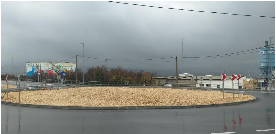
Vizura iz pravca PZ Ivanji na INA-in spremnik, prirodnu šumsku vegetaciju i postrojenje „Zidara“
